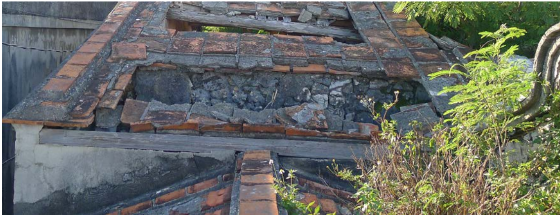
照片 4-6：大厝身左右前方屋面的屋坡磚坪（本研究拍攝）
