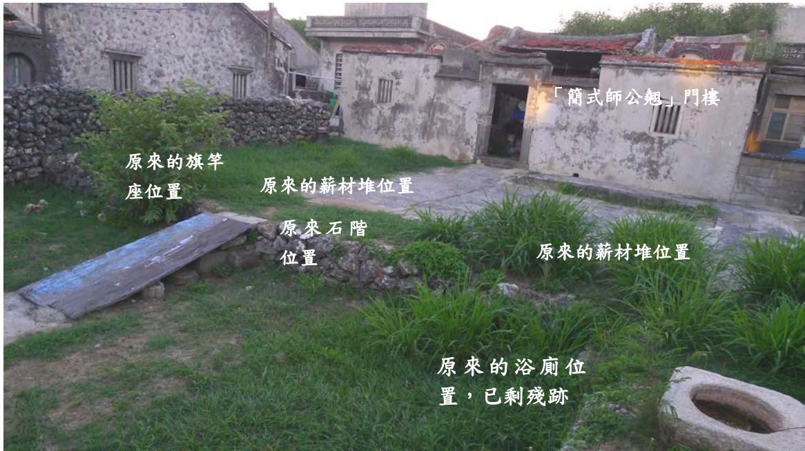
照片4-7：古宅門樓前方的前院設施位置（本研究拍攝）
