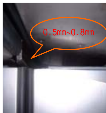
圖十四 調整天花板支撐架間隙
