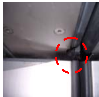
圖十五 鋸除框架側天花干涉點板
